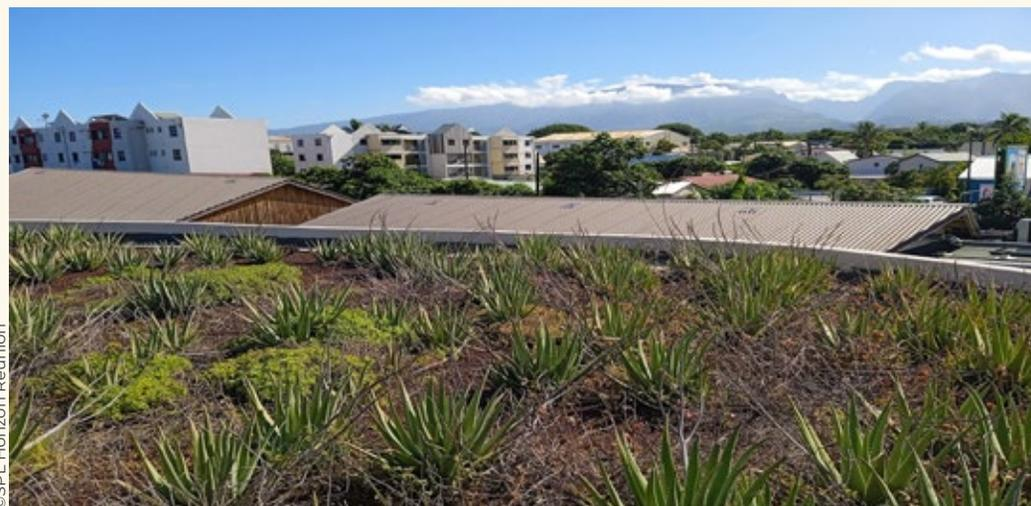
Les toitures végétalisées : une solution d'isolation à mettre en œuvre avec précaution.
